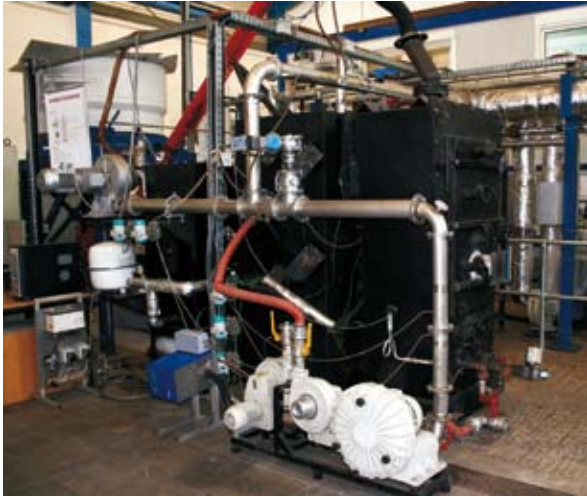
Die Wirbelfeuerungsanlage im Versuchsstand des ATZ Entwick- lungszentrums
